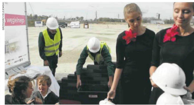
Wczorajsza uroczystość wmurowania kamienia węgielnego była symbolicznym początkiem inwestycji, bo koparki na placu budowy pojawiły się już kilka tygodni temu. Po przygotowaniu terenu inwestycja ruszy pełną parą
